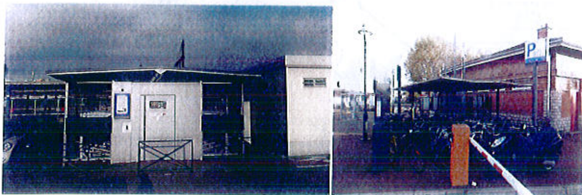
Station Véligo et arceaux couverts en gare de Corbeil
