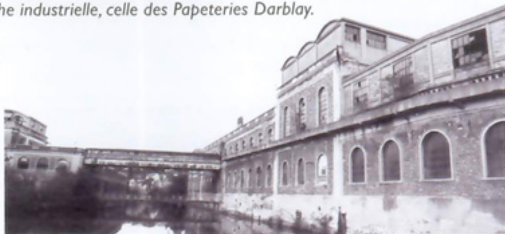
Le bâtiment principal
